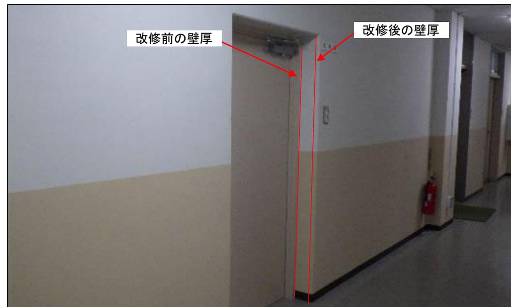
○ 壁厚を厚くし、せん断剛性を高める耐震補強を実施したことにより、地震による被害を回避した。
