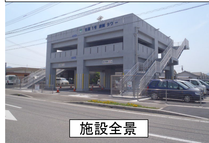
津波避難タワー
