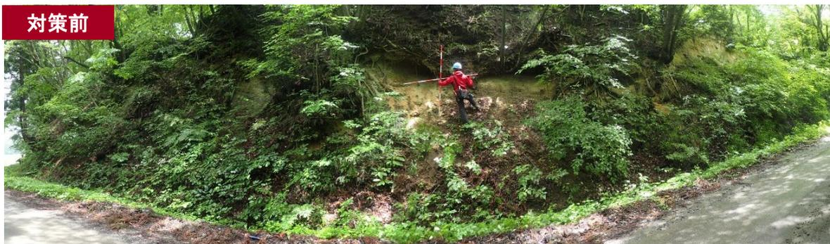
令和2年度～令和3年度に、秋田内陸線に隣接する斜面に法面固定による斜面の崩壊対策を実施(対策箇所上部が線路)
