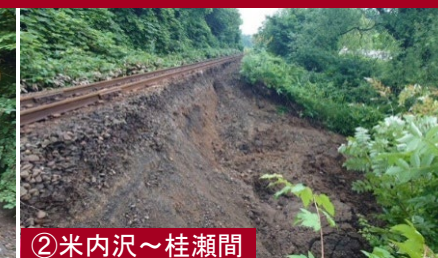
令和6年7月25日からの大雨による秋田内陸縦貫鉄道の被害例
