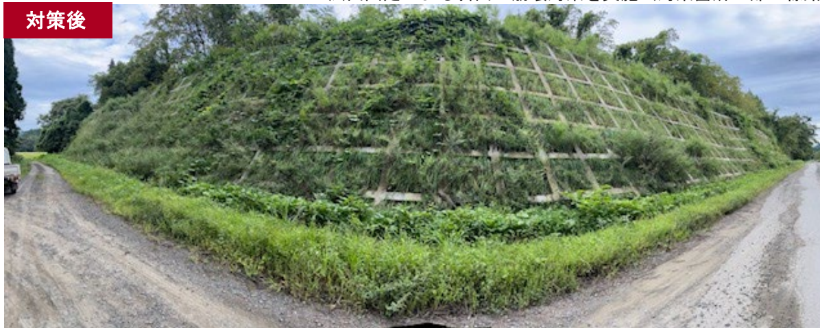
令和2年度～令和3年度に、秋田内陸線に隣接する斜面に法面固定による斜面の崩壊対策を実施(対策箇所上部が線路)
