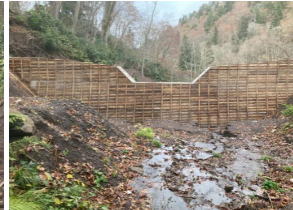
上流側から見た状況
