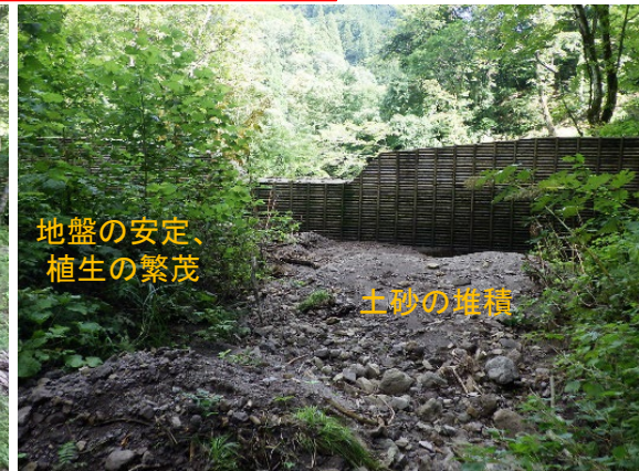
上流側から見た状況
