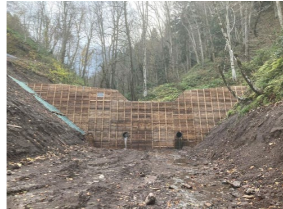
下流側から見た状況
