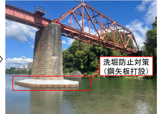
洗掘防止対策(鋼矢板打設)
