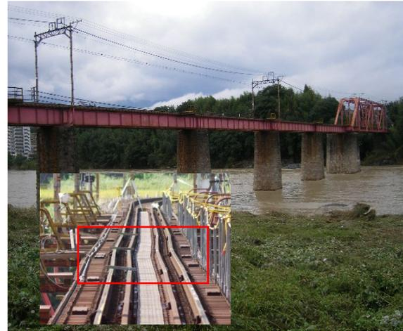
洗掘により橋脚が傾斜し、軌道狂い発生(平成23年9月)
