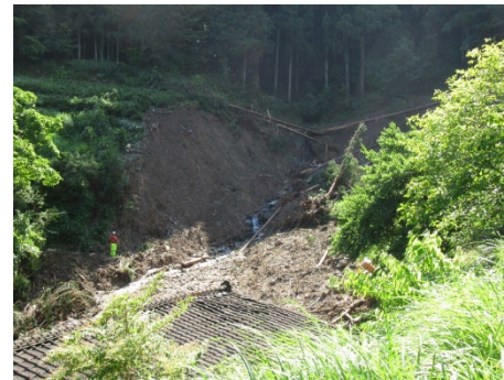
土砂災害現場
