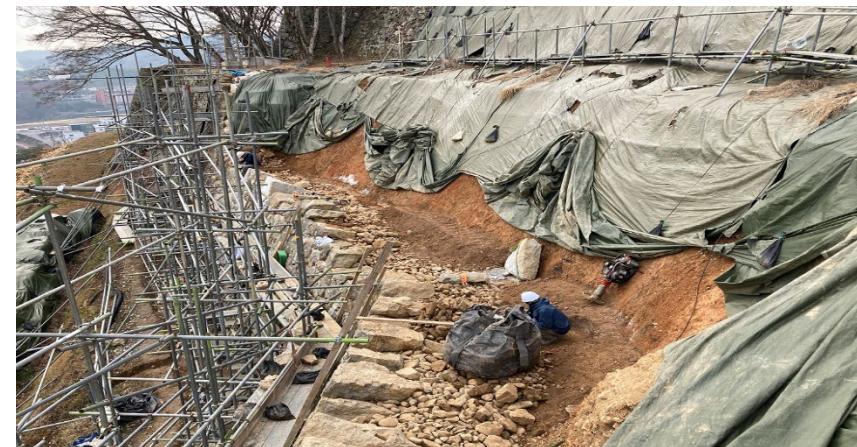
老朽化対策工事
