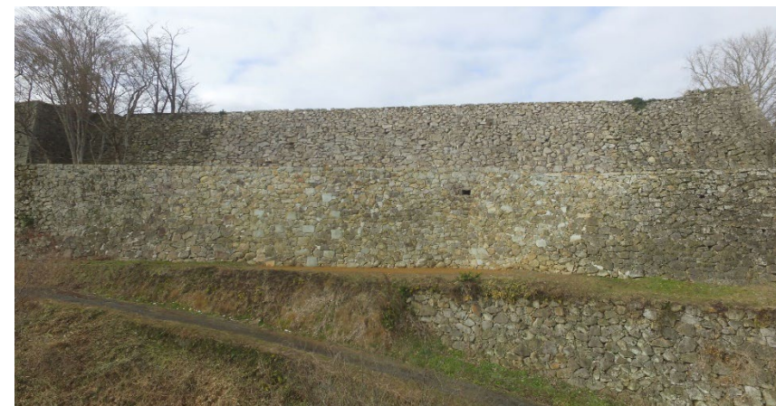
老朽化対策工事完了
