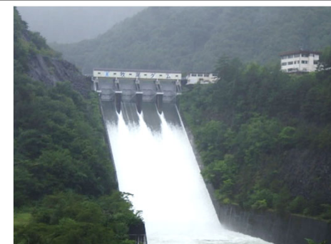
牧尾ダム(長野県)事前放流状況
