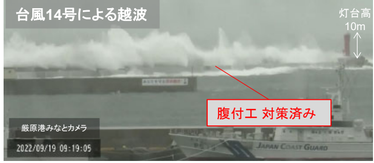
【整備後:令和4年台風第14号による防波堤(北)の状況】
