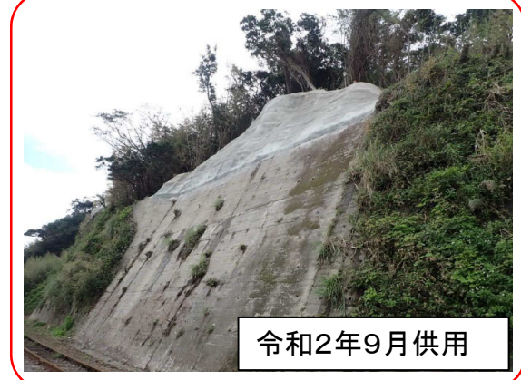
法面对策を実施した結果、被害なし (令和4年9月台風)
