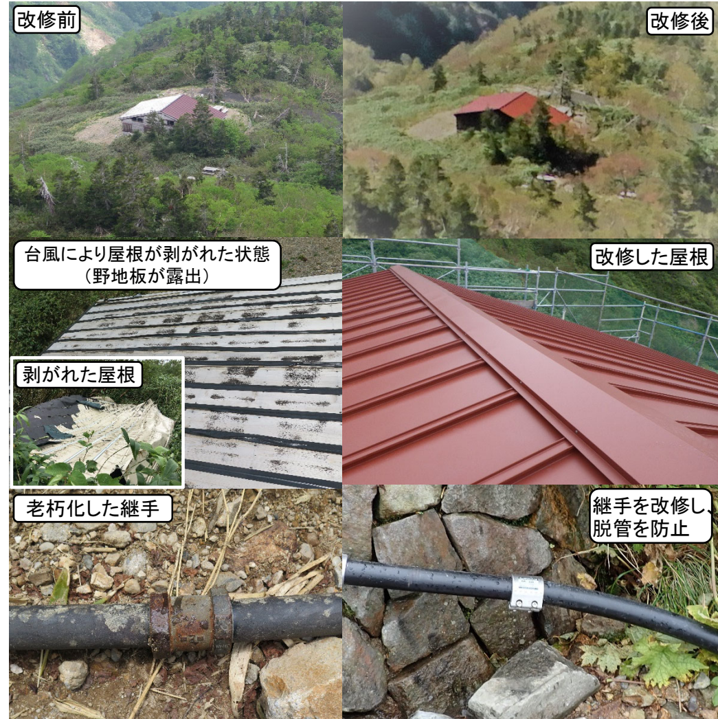
屋根及び給水管の改修前後の様子
