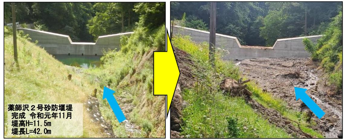
**概要:** 平成25年8月豪雨では、累加降水量約394mmの大雨に伴う法面崩壊等の被災を受け、約3日間の通行止めが発生。被災箇所の応急復旧を行ったのち、5か年加速化対策として法面对策を実施した結果、令和4年8月の大雨では平成25年8月豪雨を上回る累加降水量約467mmの大雨を観測したが、大雨による変状等が生じることなく、交通機能を確保。
