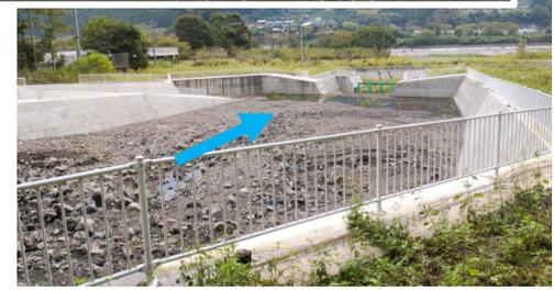
効果概要: 土砂災害発生の危険性が高い溪流である富士川水系塩島沢において、3か年緊急対策予算を用いた国直轄事業による砂防堰堤の整備により、令和4年台風第15号に伴い発生した土石流約900m<sup>3</sup>を捕捉し、下流域の人家や学校、県道への被害を未然に防止。
