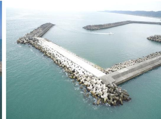
防波堤(新設、粘り強い化)
