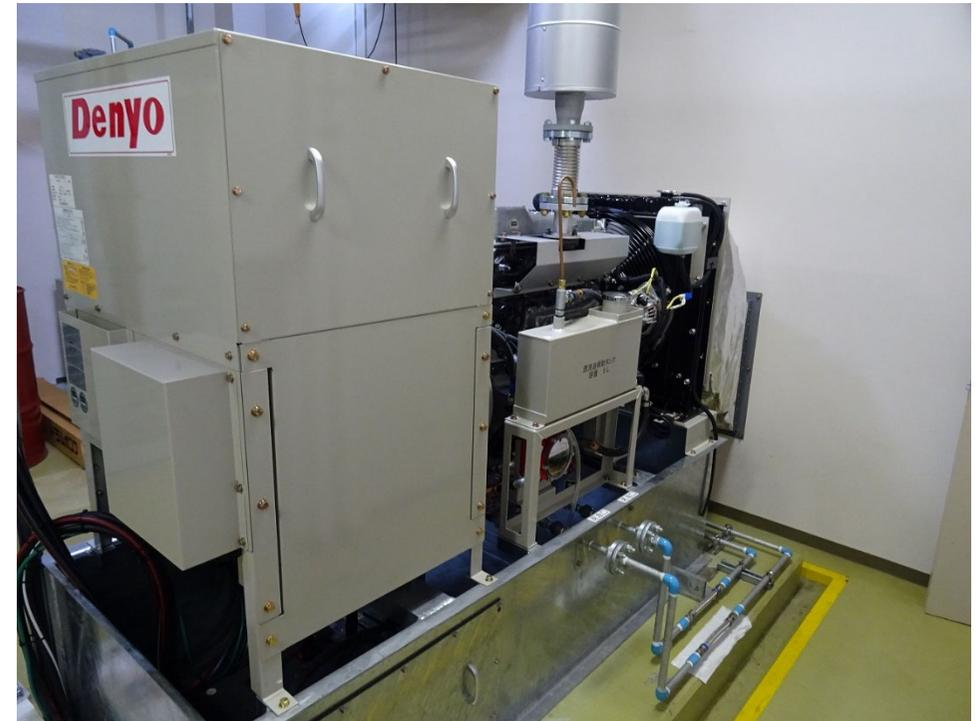
警察通信の維持のために更新した無線中継所の非常用電源設備
