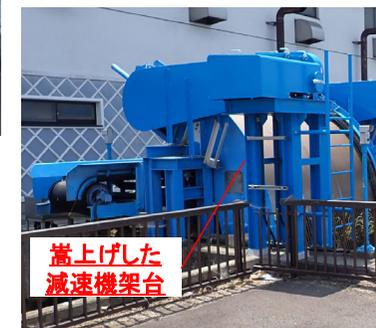
除塵設備の浸水対策
