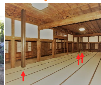
本堂内部(修理・補強後) 鉄骨フレーム(赤矢印部分、 木材カバー付)による 耐震補強を実施
