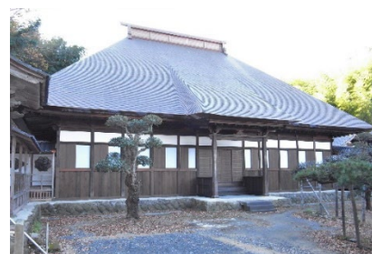
本堂外観(修理・補強後)
