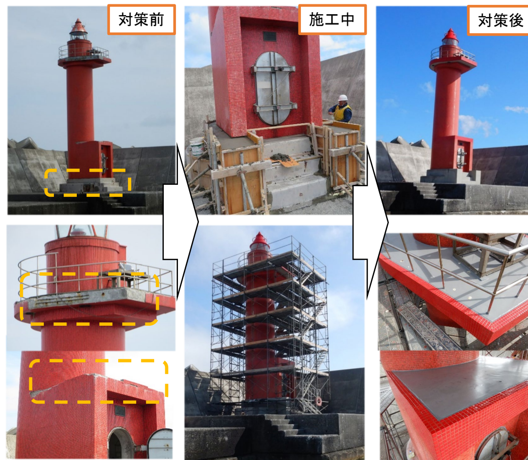
稚内港北副防波堤東灯台
