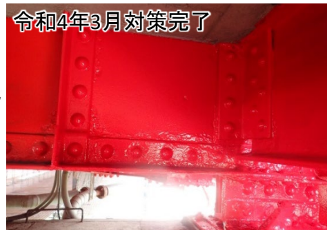
腐食除去・再塗装
