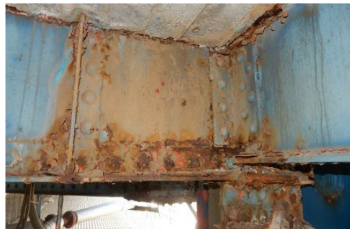
主桁の腐食
