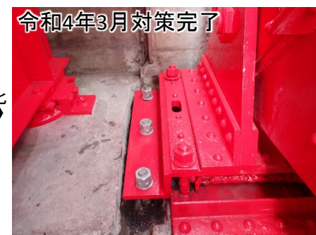
再塗装、アンカーボルトの設置
