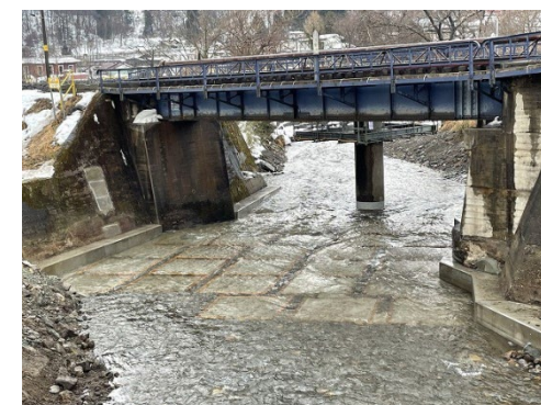
対策後(令和4年2月)
