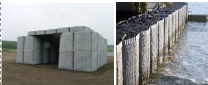
【簡易防護壁(箱型土のう)】【河川氾濫時の塞き止めの様子】
