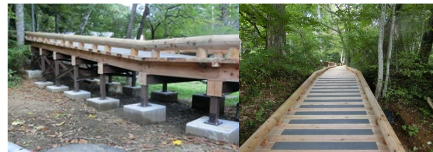
再整備により対策をした木道
