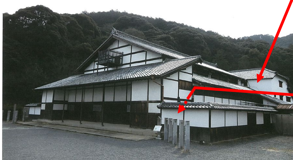
補強完了後 外観
