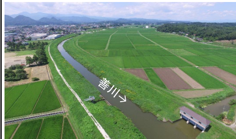
整備前(令和元年8月撮影)
