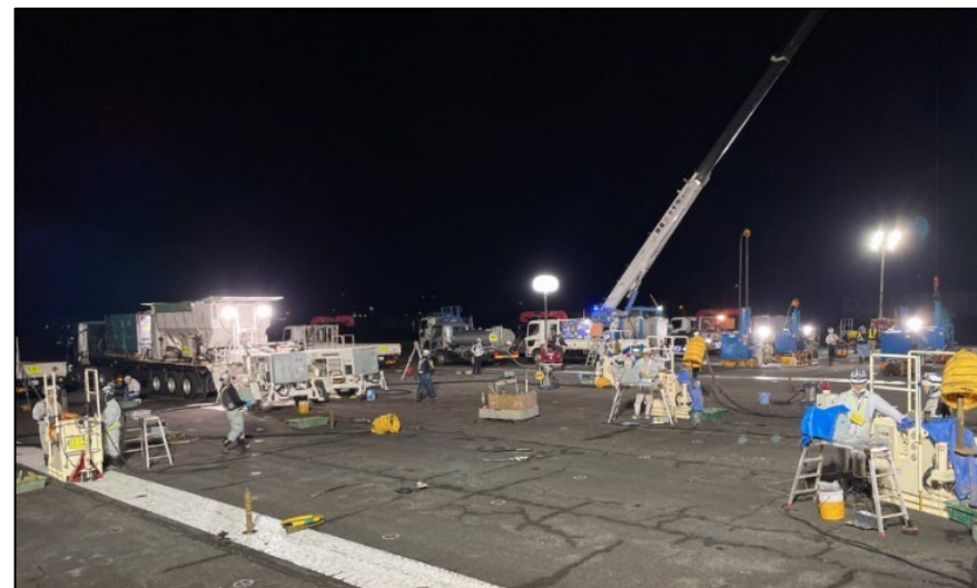
〔滑走路の耐震対策 施工状況〕
