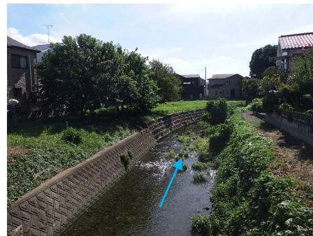
整備前(令和3年8月撮影)
