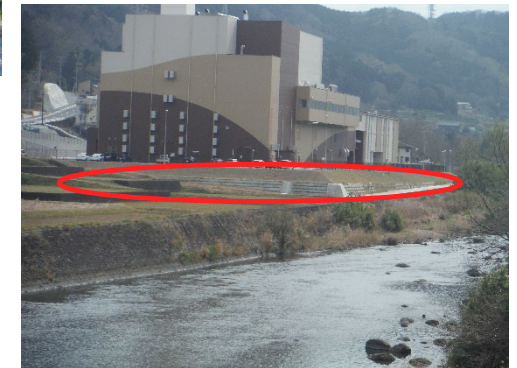
狩野川洪水浸水想定に対応した敷地地盤高のかさあげ状況
