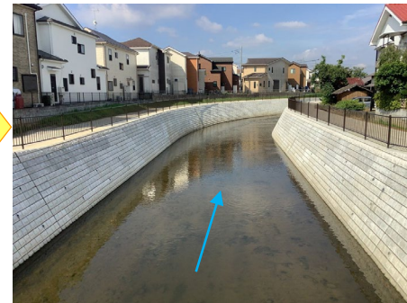
整備後(令和4年8月撮影)
