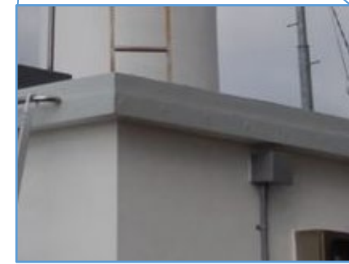
▲外壁欠損部補修、防水工事
