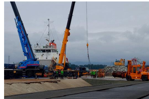
3号ふ頭 岸壁(-12m、耐震) 応急復旧工事完了(3/21)
