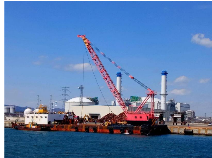
3号ふ頭 岸壁(-12m、耐震) 3/28工事用資材荷役(積込み)
