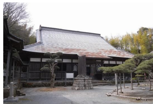
本堂外観(修理前)
