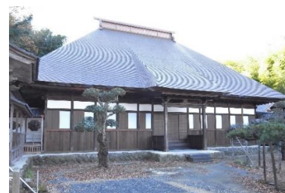
本堂外観(修理・補強後)
