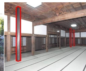
本堂内部(修理・補強後) 鉄骨フレーム(赤囲み部分、 木カバー付)による 耐震補強を実施
