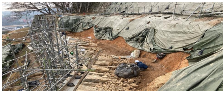
石垣整備：一旦解体し栗石や裏込石を詰め直し作業
