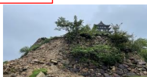
整備が遅れて石垣が崩落
