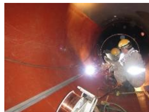
管内で鋼管を溶接
