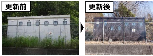
老朽化した受変電設備の更新
