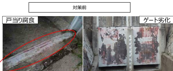
引き上げ式ゲート（開閉操作が必要）
