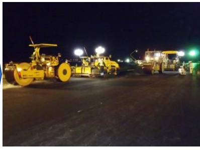
老朽化した滑走路舗装の改良
