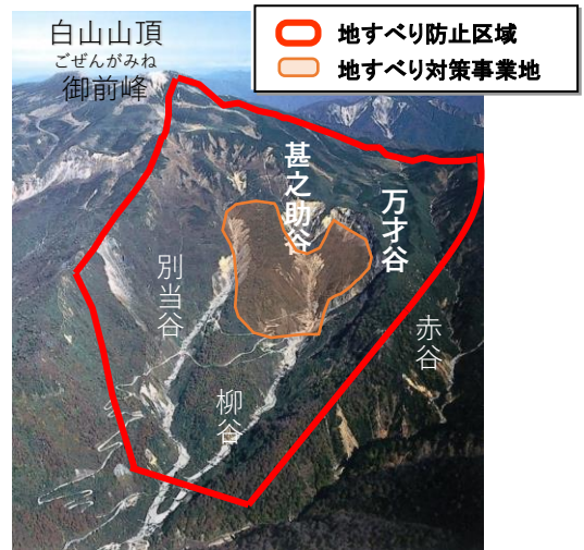
甚之助谷地区地すべり
