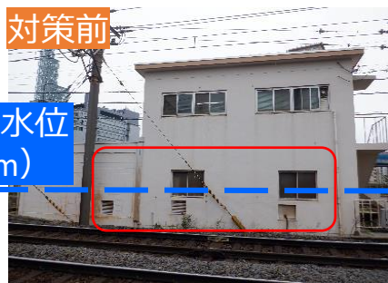
窓・ガリ封鎖、外壁防水塗装
