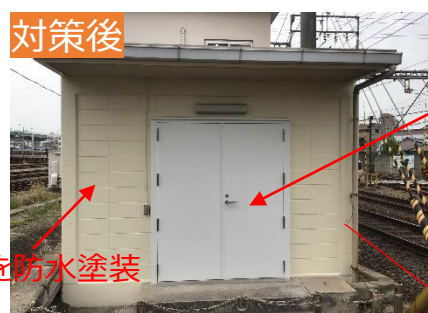
防水扉設置、外壁防水塗装
