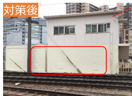
窓・ガリ封鎖、外壁防水塗装
