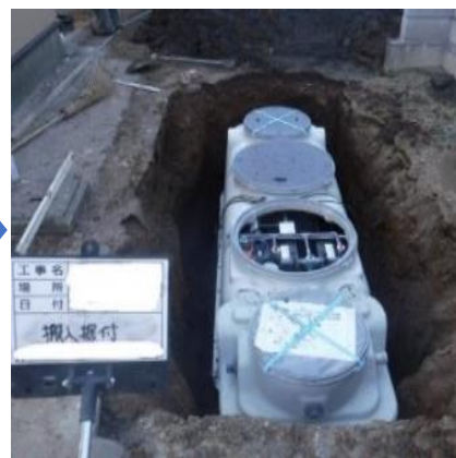
合併処理浄化槽設置
