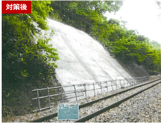
コンクリート吹付による法面固定
