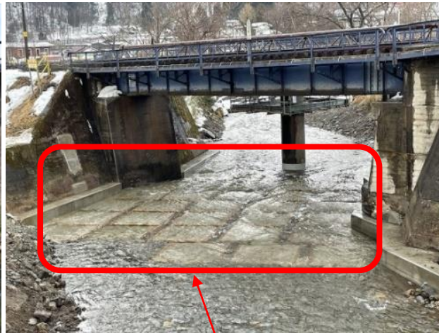
川床へのブロック設置
