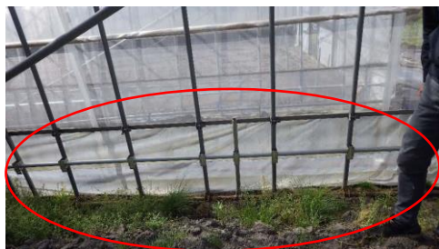
埋込パイプ、横直管パイプの追加
