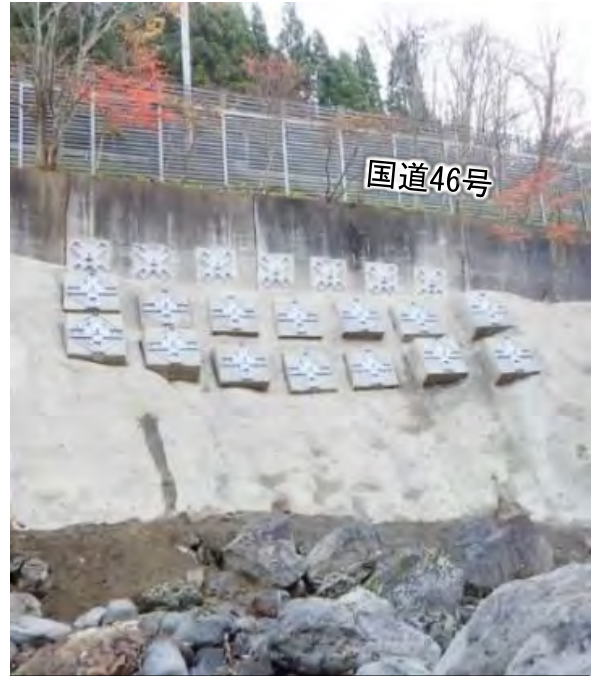
法面对策（道路の下側から撮影）
