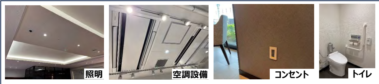
災害時に活用可能な設備（一例）
