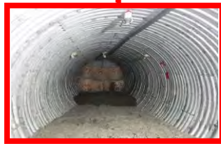
②坑道内整備（暗渠排水設置、路面整備）
