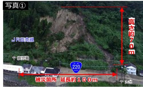
▲写真① 国道220号の被災状況(R3.9)
