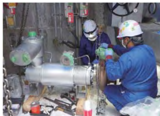
補修等の写真
