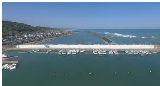
北防波護岸（改良、かさ上げ）
