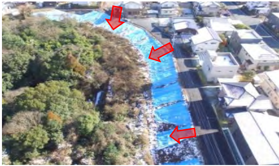
平成28年熊本地震により発生した造成宅地の滑動崩落
