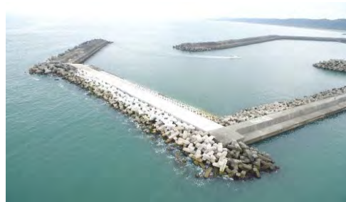
防波堤（新設、粘り強い化）
