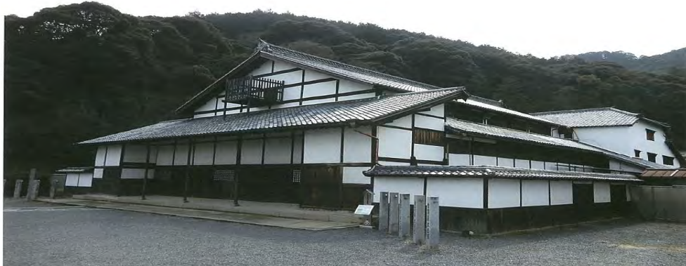
補強完了後 外観
