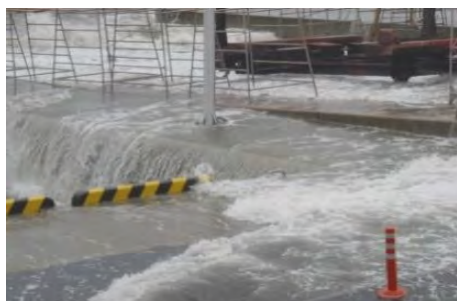
越波による浸水（平成23年台風12号）
