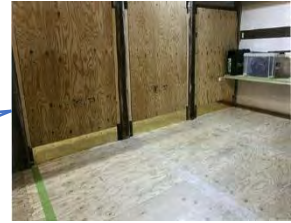
構造用合板補強 (壁・床の内部に設置)
