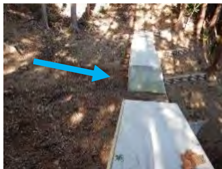
治山ダムが流出土砂を捕捉
