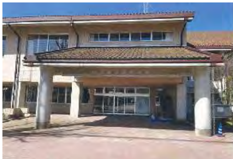
体育館の外観
