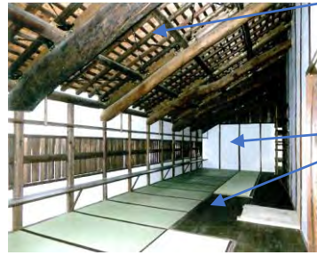
二階楽屋 補強完了後
