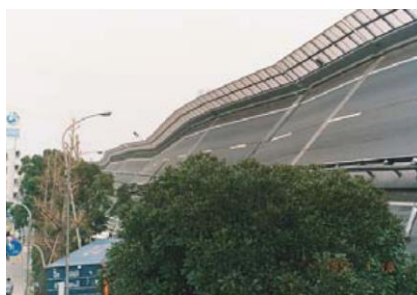
阪神高速道路の高架橋の倒壊 (写真提供：神戸市)
