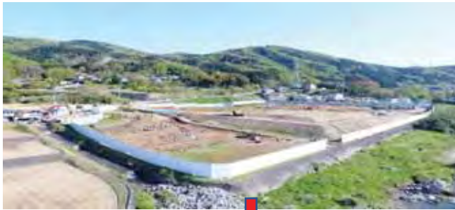
狩野川洪水浸水想定に対応した敷地地盤の嵩上げ状況
