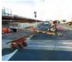
信号柱の倒壊
