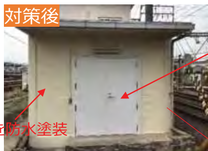
防水扉設置、外壁防水塗装
