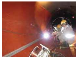
管内で鋼管を溶接
