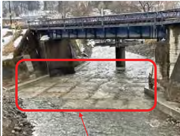
川床へのブロック設置
