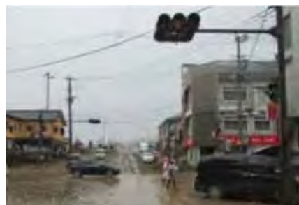
令和2年7月豪雨において滅灯した信号機
