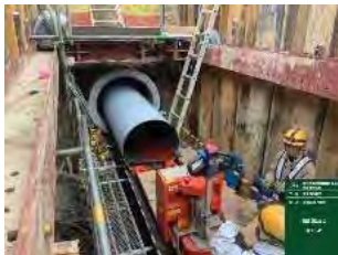
既設管の中に耐震性のある鋼管を挿入するPIP（パイプインパイプ）工法の実施
