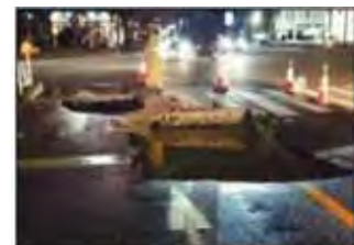
下水道に起因した道路陥没
