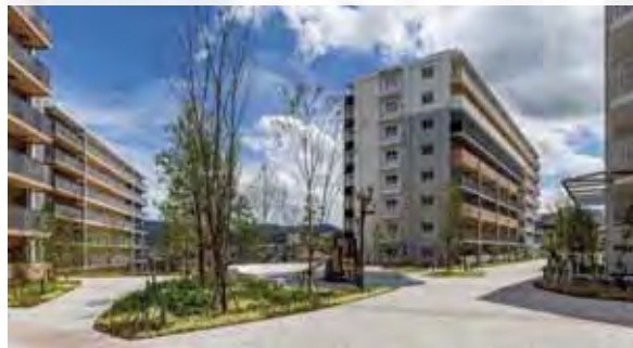
非常時の滞留空間として、団地内を貫通するバリアフリーな通路・オープンスペースを整備
