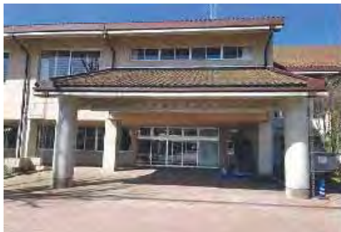
体育館の外観
