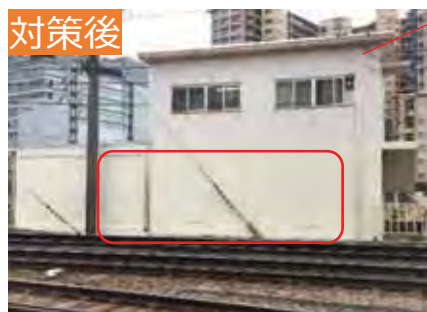
窓・ガリ封鎖、外壁防水塗装
