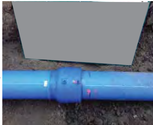
耐震性・耐候性の高いポリエチレン管へ更新
