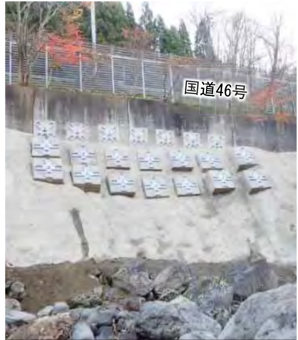
法面对策（道路の下側から撮影）
