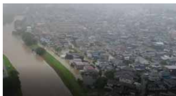
令和5年7月 秋田県秋田市内の浸水状況 (出典：東北地方整備局HP)
