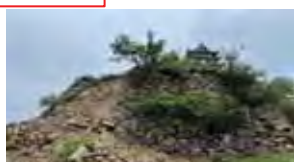
整備が遅れて石垣が崩落
