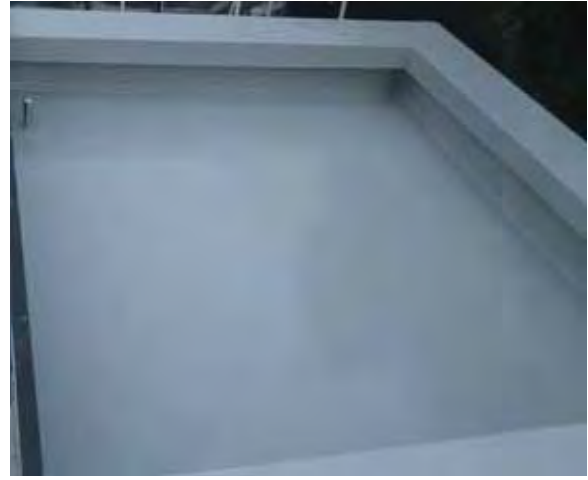
浴室棟屋上（施工後） 既存防水層を覆うようにウレタン塗膜防水を施工し、新たな防水層を形成した。
