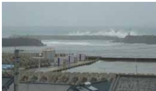
港内へ高波の進入
