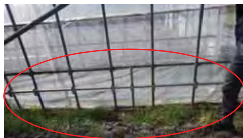
埋込パイプ、横直管パイプの追加
