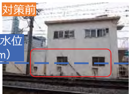
窓・ガリ封鎖、外壁防水塗装
