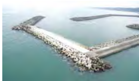
防波堤（新設、粘り強い化）
