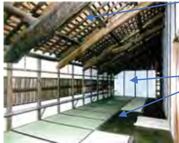
二階楽屋 補強完了後
