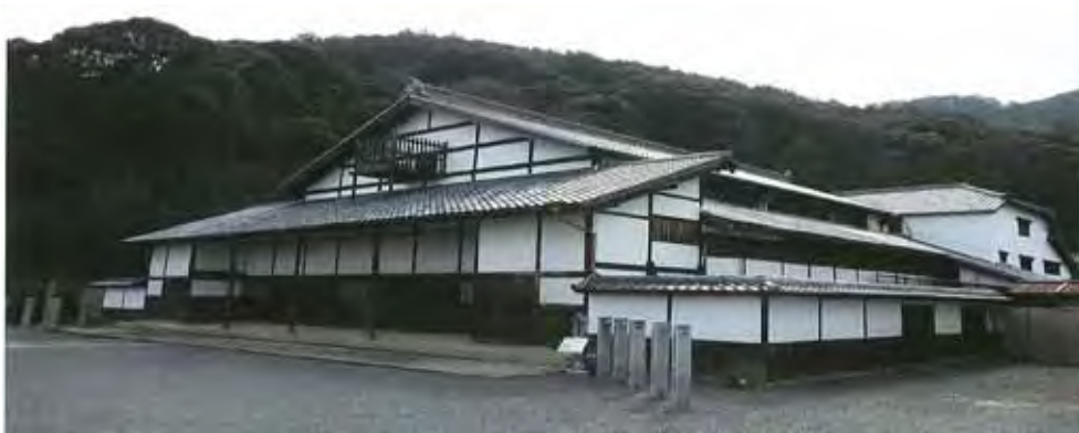
補強完了後 外観
