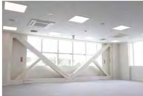
耐震改修 (枠付き鉄骨ブレース補強)
