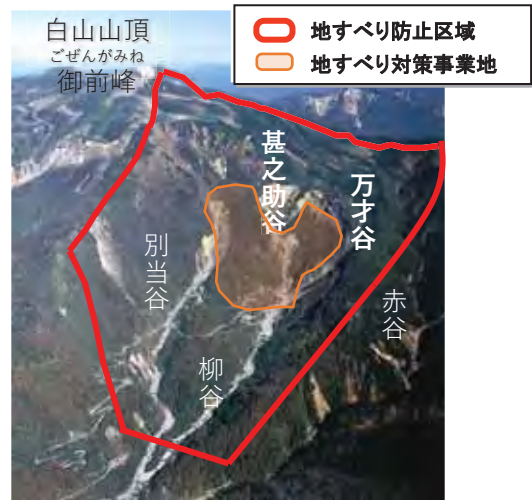
甚之助谷地区地すべり
