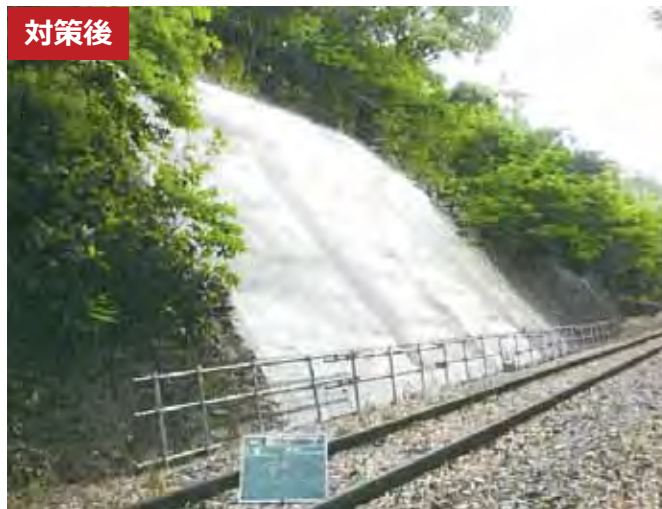
コンクリート吹付による法面固定
