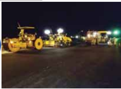
老朽化した滑走路舗装の改良
