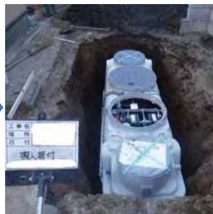
合併処理浄化槽設置
