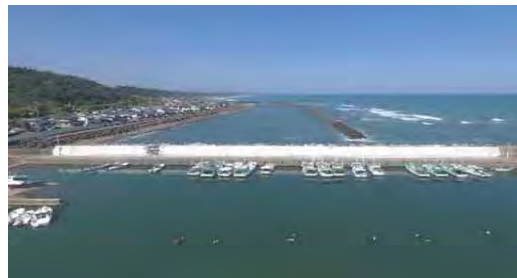
北防波護岸（改良、かさ上げ）
