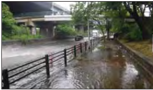
整備前（令和3年5月冠水）
