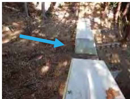
治山ダムが流出土砂を捕捉
