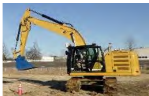
建機1台につき 搭乗するオペレータ1人が必要
