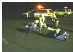
点検等による劣化・損傷 程度の確認
