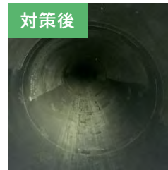
農業用水管の耐震化 (香川県さぬき市)
