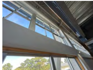
内壁、外部建具の改修状況
