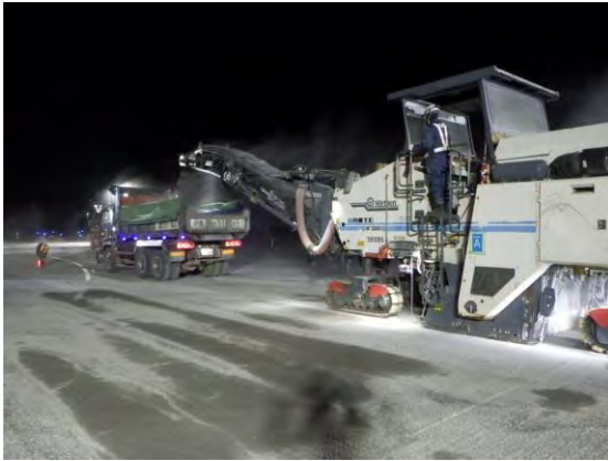
老朽化した滑走路舗装の撤去
