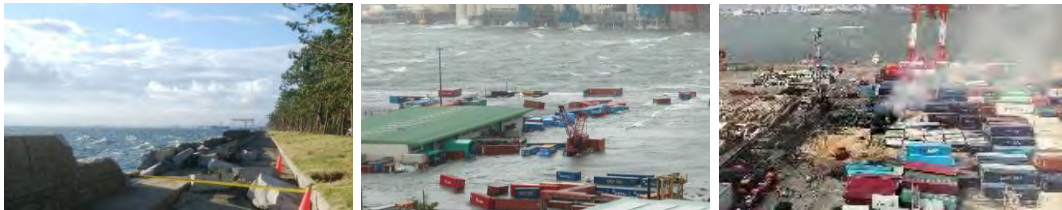
越波による護岸の倒壊
