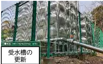
老朽化した受水槽を更新し耐震性確保
