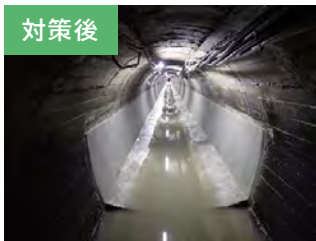
水路トンネルの補修・補強 (新潟県魚沼市)
