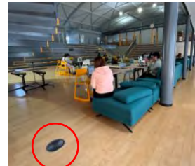
床下空調設備
