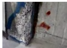
構造躯体の耐久性向上
