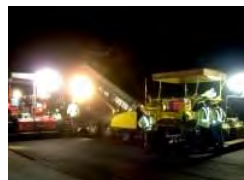
老朽化した滑走路舗装の 改良
