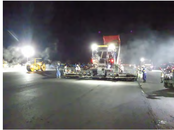
滑走路舗装の舗設
