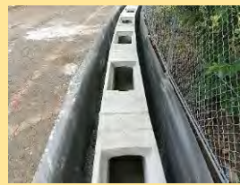
新設した浸透側溝
