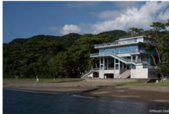
▼海からの外観
