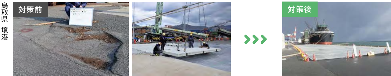
施設の老朽化により陥没等が発生していた岸壁に対し舗装工事を実施
