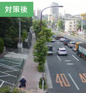
電柱の撤去により、道路の安全性を確保
