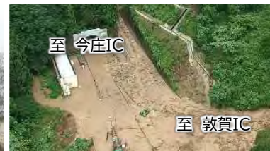
トンネル坑口部における土砂の大規模流入
