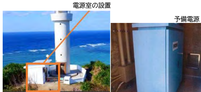
予備電源の整備又は主電源の太陽電池装置化により、停電時の灯台の消灯を防止
