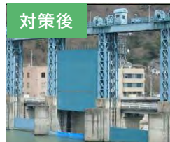
ゲート塗装(耐久性の高い塗料を使用) 劣化状況を評価の上、更新
