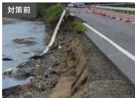
対策前 豪雨により隣接する河川が増水し、道路の一部が流出
