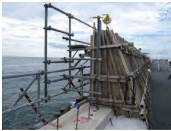
既存護岸の嵩上げ
