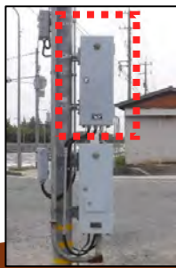
リチウムイオン電池式 (整備例:鳥取県)
