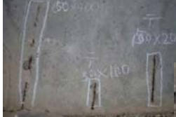
損傷状況(橋脚鉄筋露出)
