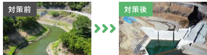
貯砂ダムの設置
