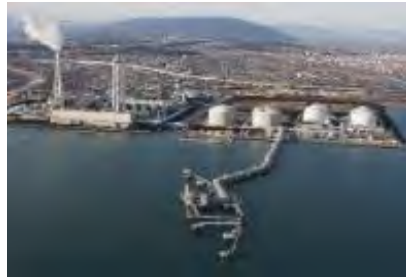
大型タンカーバース
