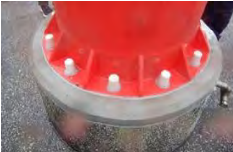
航路標識の基礎部等への海水浸入を遮断し、劣化・腐食を防ぎ、倒壊を防止
