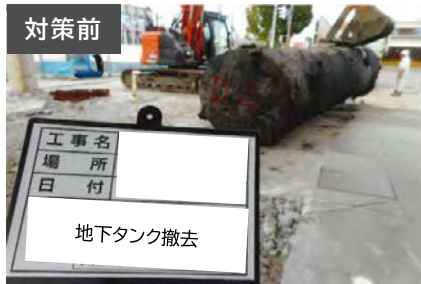
鋼製一重殻タンクの撤去及び大型二重殻タンクの設置
