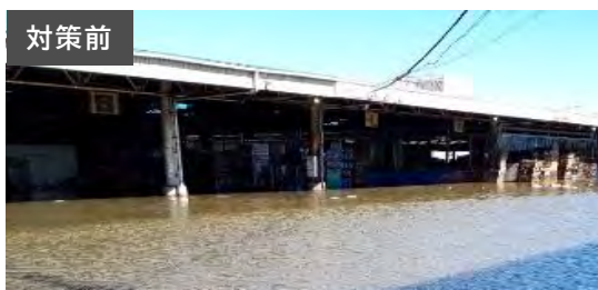
大雨による浸水被害(荷捌場)
