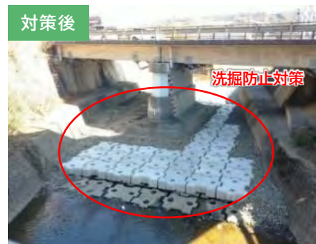
対策後 護床ブロックによる洗掘対策
