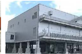
電気設備の地上化
