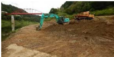
京都府 高山ダム
