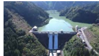
埼玉県 合角ダム
