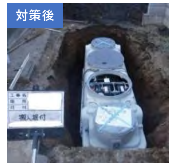
合併処理浄化槽設置
