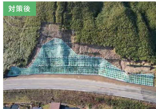
同区間において法面対策を実施
