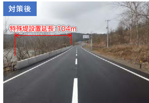
道路沿いに特殊堤を設置
