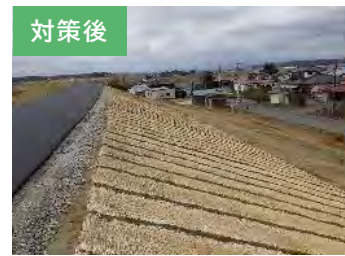
対策後 堤防法面の補修
