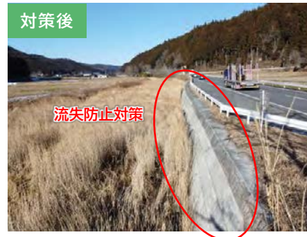
対策後 道路流出対策を実施
