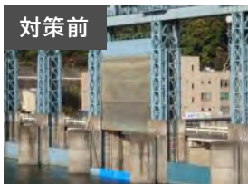
ゲート塗装(耐久性の高い塗料を使用) 劣化状況を評価の上、更新
