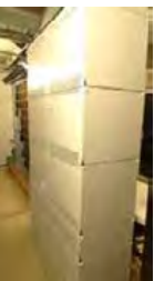
経年劣化した電話交換設備の更新
