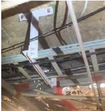
天井内吊り材補強
