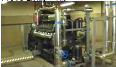
自家発電設備の改修
