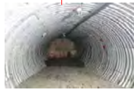
②坑道内整備
