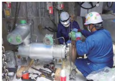
処理施設における補修作業
