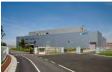
JESCO(高濃度PCB廃棄物処理施設)
