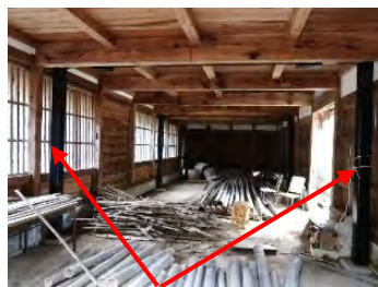
鉄骨補強、耐圧板設置
