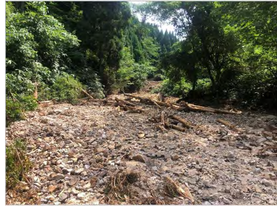
令和3年7月豪雨の被災状況
