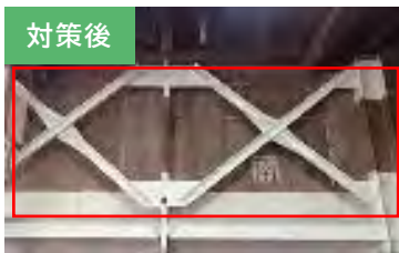
壁面への耐震ブレースの設置
