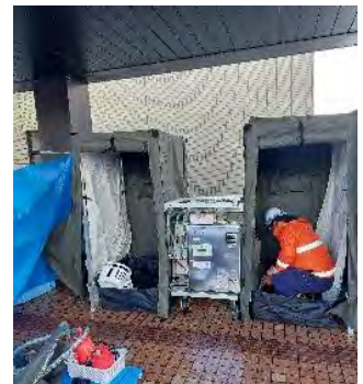
シャワーブース設置状況
