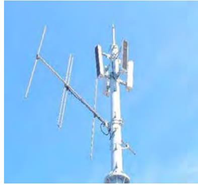
<防災行政無線 屋外スピーカー>
