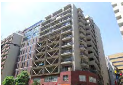
耐震改修を実施した建築物
