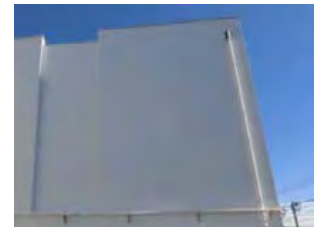
外壁剥離等の落下対策
