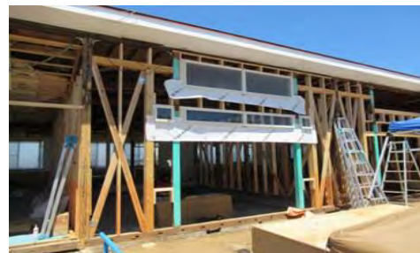
整備中の様子
