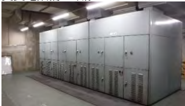
受変電設備の改修
