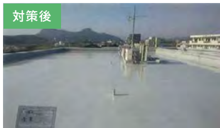
防水性の確保(屋上に防水塗装を施工)
