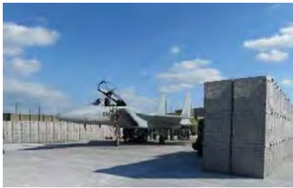
航空機及び施設等の防護、大雨等の際の事前の設置による冠水等の防止、災害発生時における土砂の土留めや河川氾濫時の塞ぎ止め等が可能
