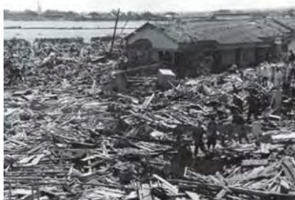
伊勢湾台風の被害状況 (写真提供:愛知県)
