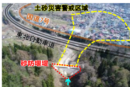
土石流を捕捉する砂防堰堤を整備
