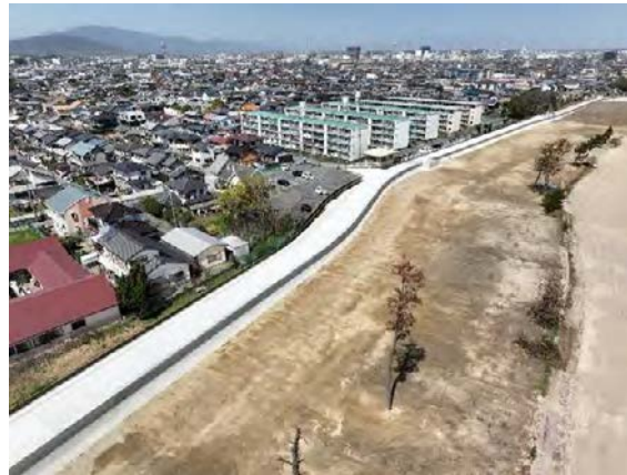
高潮等から市街地を防護する海岸堤防の整備
