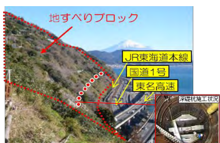
地すべりを防ぐ深礎杭等を整備
