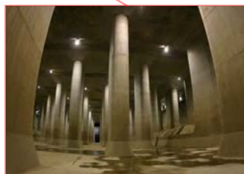
首都圏外郭放水路(調圧水槽)
