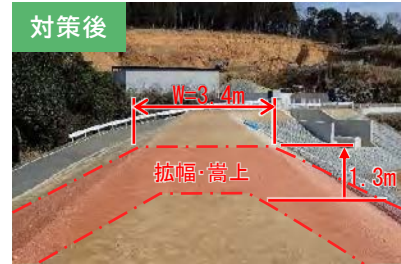
堤体の拡幅・嵩上(W=3.4m,h=7.0m)
