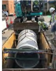
既設下水道管の増径
