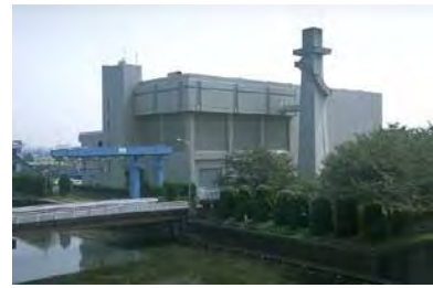
排水機場の整備
