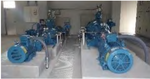
排水機場の更新(ポンプ口径の拡大等)により、排水能力を向上
