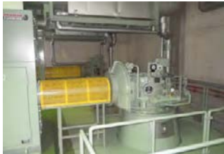
排水ポンプの増設
