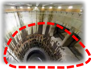
首都圏外郭放水路 第1立坑から調圧水槽への流入状況
