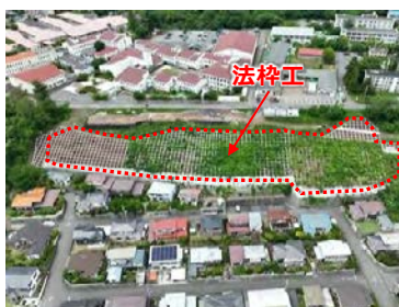
がけ崩れを防ぐ法枠工を整備
