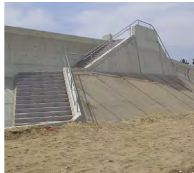
階段・スロープ等の整備
