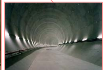
シールドトンネル
