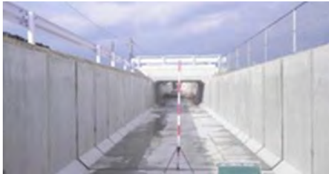
排水路の改修により、最大排水能力を向上
