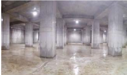
雨水調整池の整備
