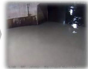
首都圏外郭放水路 第1立坑から調圧水槽への流入状況
