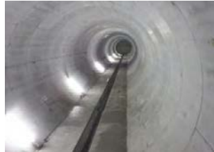
雨水貯留管の整備
