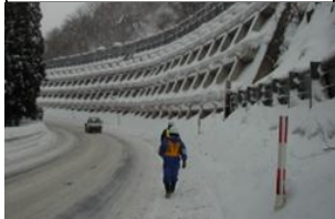
人による現地確認の様子
