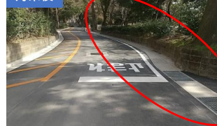
雨水排水用の浸透側溝を新設する事で排水能力が向上し、令和5年の大雨では被害が発生しなかった(1日あたり190mmの降水量を観測)
