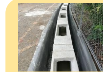
新設した浸透側溝
