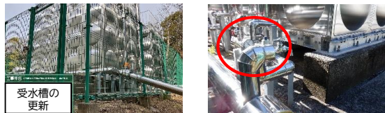
老朽化した受水槽を更新し耐震性確保
