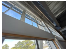
内壁、外部建具の改修状況
