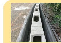
新設した浸透側溝
