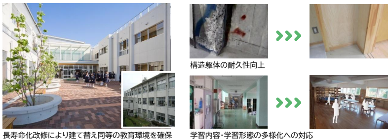
長寿命化改修により建て替え同等の教育環境を確保
