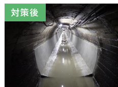
水路トンネルの補修・補強 (新潟県魚沼市)
