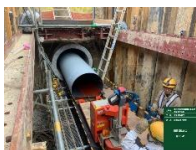
既設管の中に耐震性のある鋼管を挿入する工法(PIP工法)の実施
