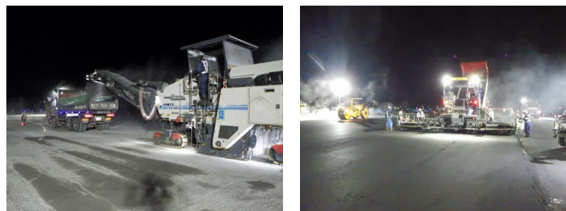
老朽化した滑走路舗装の撤去
