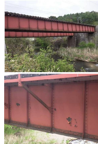
橋梁の老朽化が進行
