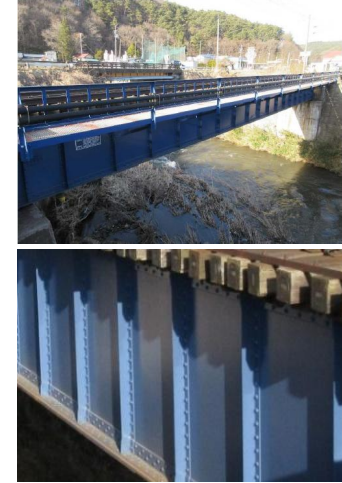
高耐久性・重防食塗料の塗装により長寿命化や維持管理コストの低減が期待される
