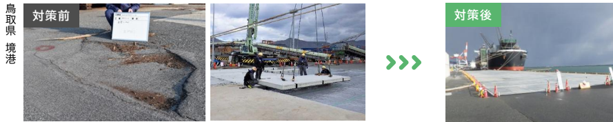
施設の老朽化により陥没等が発生していた岸壁に対し舗装工事を実施
