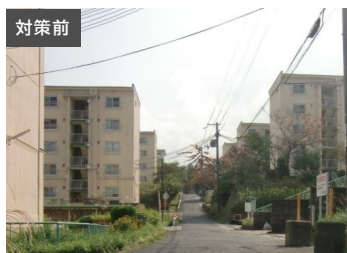
老朽化した旧耐震基準の階段室型市営住宅を現行の耐震・耐火基準に適合するよう建替える必要があった
