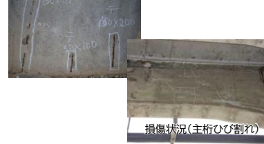
損傷状況(橋脚鉄筋露出)
