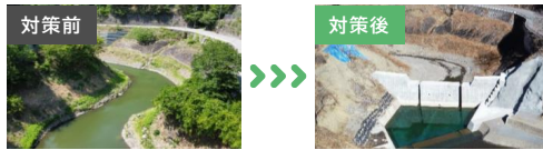
貯砂ダムの設置
