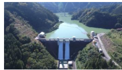
埼玉県 合角ダム
