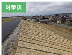
堤防法面の補修
