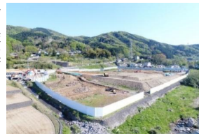
敷地地盤の高上げ(浸水対策)
