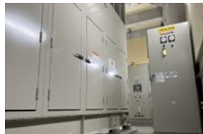
非常用発電設備の設置
