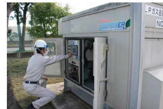
非常用発電機の設置
