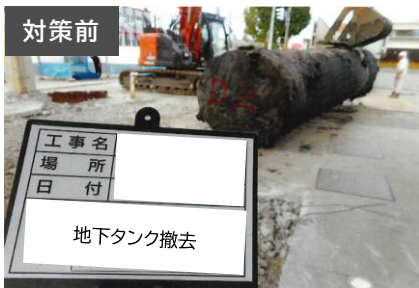
鋼製一重殻タンクの撤去及び大型二重殻タンクの設置
