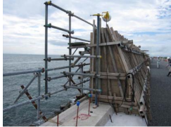
既存護岸の嵩上げ
