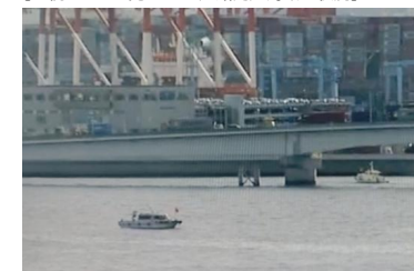
【監視カメラで見た はま道路周辺海域の状況】
