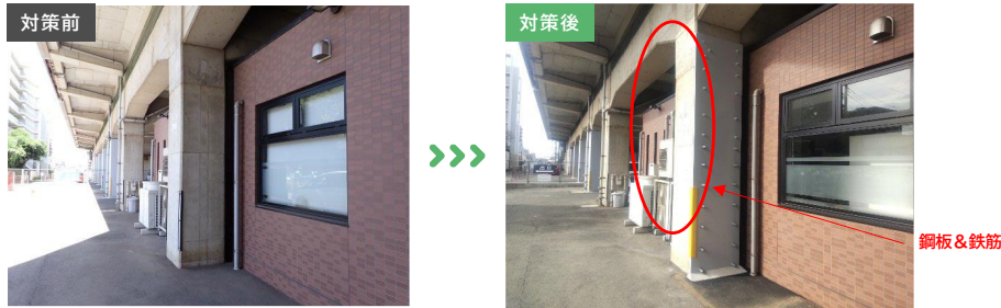
橋脚の耐震性が向上し、地震による損傷を防止
