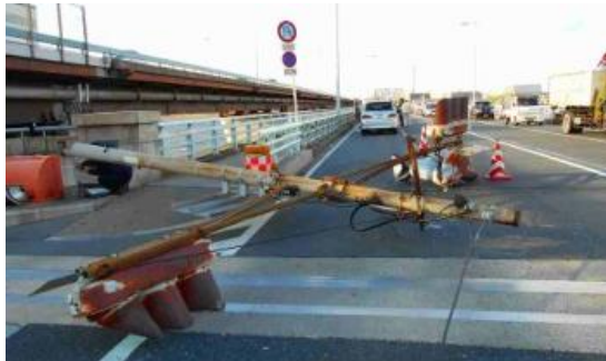
信号柱の倒壊
